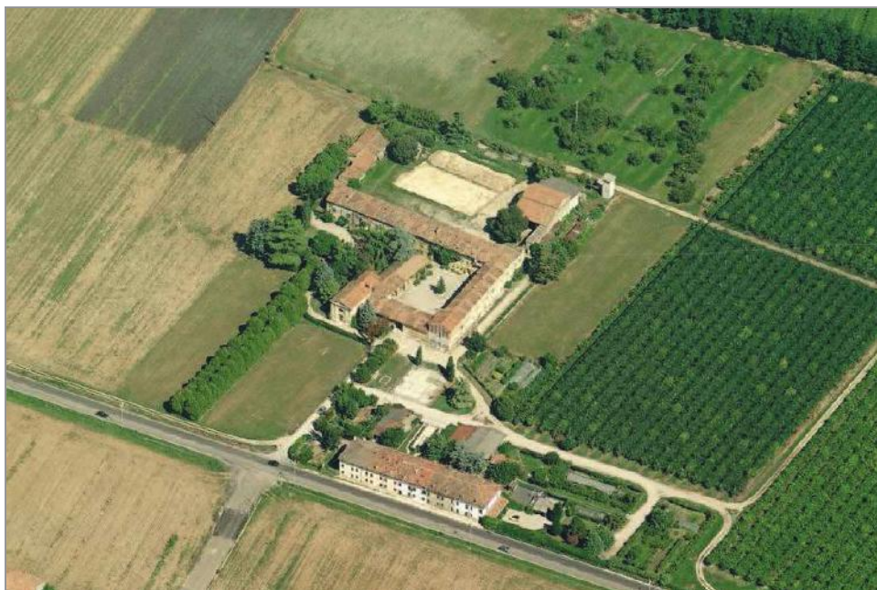
Figura 3: Vista del sito d'intervento
